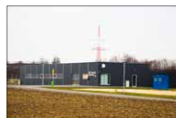
Stocksporthalle Seiersberg Haushamer Straße 20, 8054
