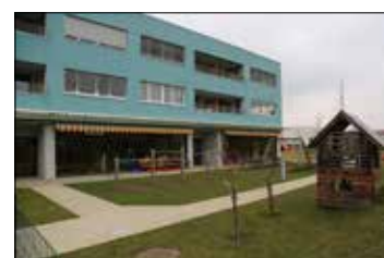
Kindergarten Sandgrubenweg Sandgrubenweg 15, 8055
