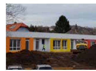
Kindergarten Pirka Rauscherstraße Rauscherstraße 3 8054 Seiersberg-Pirka Tel.: 0664 8410308 kgpka2@seiersberg-pirka.at
