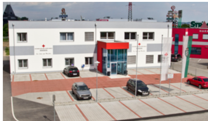
▲ 2013 wurde das Einsatzgebäude in der Haushamerstraße 10 bezogen. Ebenfalls in diesem Gebäude untergebracht ist das Bezirkskommando GU
