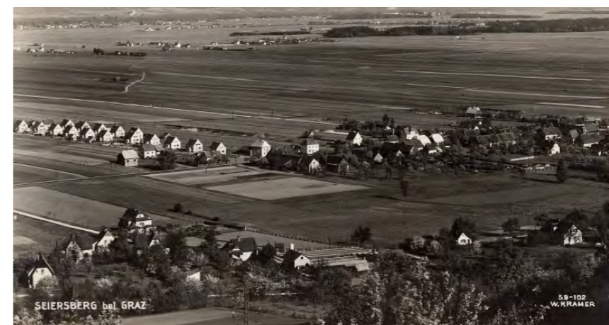
So sah unsere Gemeinde zu Baubeginn der Wasserversorgung im Jahr 1969 aus
