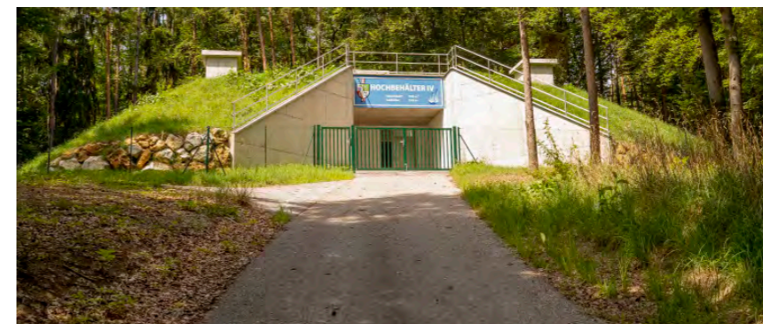
In Hochbehältern wie diesem wird unser Wasser gebunkert
